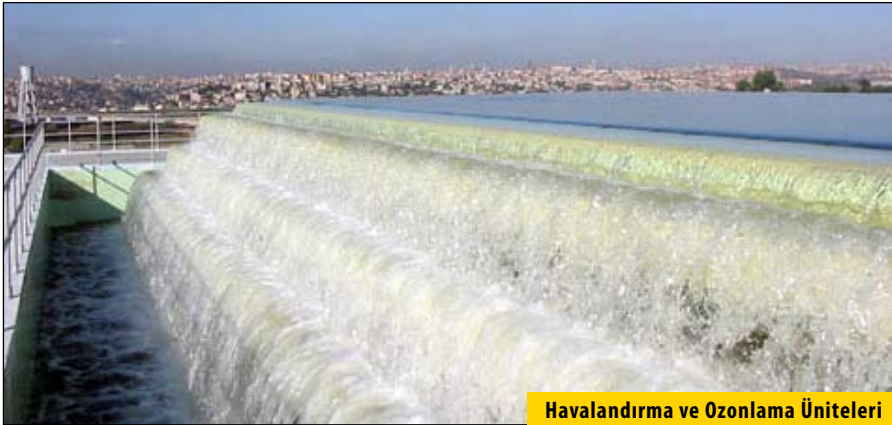
İçme Suyu Arıtma Tesisleri
